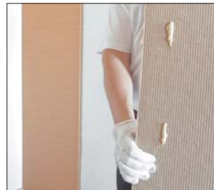
Монтаж декоративных панелей ISOTEX степлером или на клей
