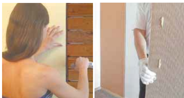
Монтаж декоративных панелей ISOTEX степлером или на клей
