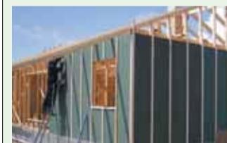
Поверх плиты ISOPLAAT ставим вертикальные рейки, тем самым достигая полной герметичности здания. Прибываем вагонку и красим.
