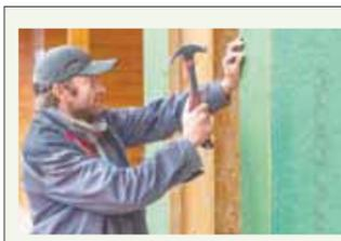
Ветрозащитная плита ISOPLAAT толщиной 12 мм соответствует 44 мм дерева. Крепится непосредственно к поверхности наружных стен деревянного дома.
