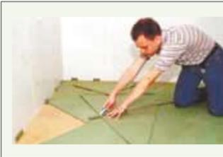
Хвойная подложка ISOPLAAT толщиной от 4 до 7 мм будет служить как теплозвукоизоляция ламинатного или паркетного пола.
