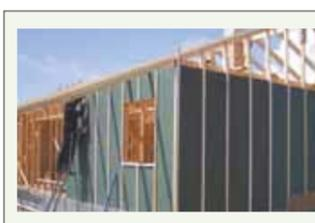
Поверх плиты ISOPLAAT ставим вертикальные рейки, тем самым достигая полной герметичности здания. Прибаваем вагонку и красим.
