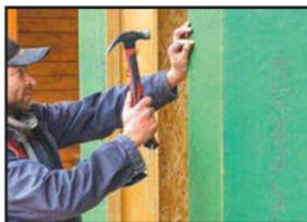
Ветрозащитные плиты ИЗОПЛАТ толщиной 12 мм по теплоизоляции равны 44 мм дерева и крепятся непосредственно к поверхности наружных стен деревянного дома, без дополнительной подготовки. Прижал и прибил. Максимально просто. Используются обычные гвозди. Плиты с прямой кромкой, но для кровли есть шип-паз. Справится один человек за день.
