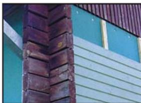
Поверх плиты ИЗОПЛАТ прибиваются рейки, а на них устанавливается «вентилируемый фасад» из обычной вагонки, которую можно сразу красить. Это самое бюджетное решение. Вместо обшивки вагонкой плиты можно, например, оштукатурить.
