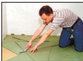
Хвойная подложка на пол обладает такими же высокими звукоизоляционными и теплоизоляционными свойствами, как стандартная плита ИЗОПЛАТ. Плюс к этому – выравнивает поверхность. Режется обычным строительным ножом.
