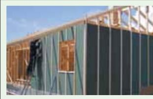
Поверх плиты ISOPLAAT ставим вертикальные рейки, тем самым достигая полной герметичности здания. Прибаваем вагонку и красим.
