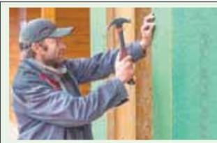
Ветрозащитная плита ISOPLAAT толщиной 12 мм соответствует 44 мм дерева. Крепится непосредственно к поверхности наружных стен деревянного дома.
