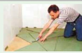
Хвойная подложка ISOPLAAT толщиной от 4 до 7 мм будет служить как теплозвукоизоляция ламинатного или паркетного пола.
