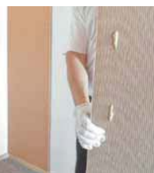
Монтаж декоративных панелей ISOTEX степлером или на клей
