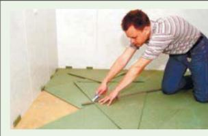
Хвойная подложка ISOPLAAT толщиной от 4 до 7 мм будет служить как теплозвукоизоляция ламинатного или паркетного пола.
