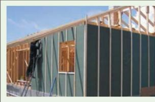
Поверх плиты ISOPLAAT ставим вертикальные рейки, тем самым достигая полной герметичности здания. Прибиваем вагонку и красим.
