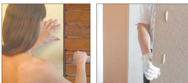
Монтаж декоративных панелей ISOTEX степлером или на клей
