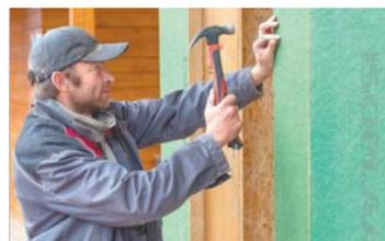
Ветрозащитная плита ISOPLAAT толщиной 12 мм соответствует 44 мм дерева. Крепится непосредственно к поверхности наружных стен деревянного или каркасного дома.
