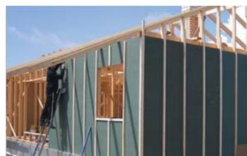
Поверх плиты ISOPLAAT ставим вертикальные рейки, тем самым достигая полной герметичности здания. Штукатурим или прибавляем вагонку.
