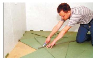
Утепляем пол плитой 12 мм или хвойной подложкой ISOPLAAT толщиной от 4 до 7 мм. Будет служить как тепло- и звукоизоляция ламината или линолеума и выравнивание бетонной стяжки.
