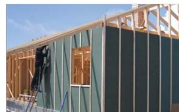
Поверх плиты ISOPLAAT ставим вертикальные рейки, тем самым достигая полной герметичности здания. Штукатурируем или прибиваем вагонку.
