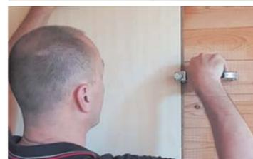
Декоративные стеновые панели ISOTEX, облицованные обоями, крепятся степлером к деревянным поверхностям или на клей к бетону.
