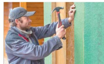
Ветрозащитная плита ISOPLAAT толщиной 12 мм соответствует 44 мм дерева. Крепится непосредственно к поверхности наружных стен деревянного или каркасного дома.
