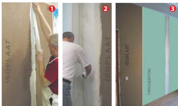
Самое простое решение для ремонта стены со звукоизоляцией — это просто прикрепить к стене на клей звукоизоляционную плиту ИЗОПЛАТ 2700 x 1200 x 12, а еще лучше 25 мм толщиной, прошпаклевать и оклеить обоями. К стене плиты легко приклеиваются на пену-клей или клей для гипрока. Если ваши соседи слушают громкую музыку или родители смотрят телевизор на максимальной громкости, тогда придется делать многослойную бескаркасную конструкцию. На приклеенный к стене лист ИЗОПЛАТ добавляется более
