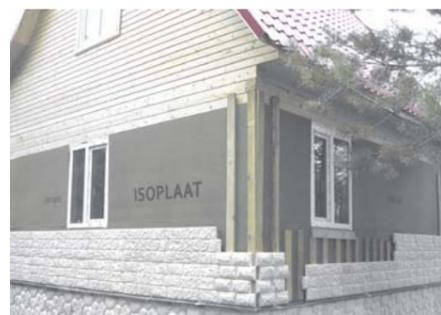
**СКАНДИНАВСКАЯ ВЕТРОЗАЩИТНАЯ ПЛИТА ISOPLAAT (ИЗОПЛАТ) — ЭТО ИДЕАЛЬНАЯ ДЛЯ НАШЕГО СЕВЕРНОГО ВЛАЖНОГО КЛИМАТА ДЫШАЩАЯ ПЛИТА ДЛЯ НАРУЖНОГО ОГРАЖДЕНИЯ И УТЕПЛЕНИЯ СТЕН КАРКАСНОГО ИЛИ ДЕРЕВЯННОГО ДОМА, А ТАКЖЕ ПОЛА И КРОВЛИ.**
