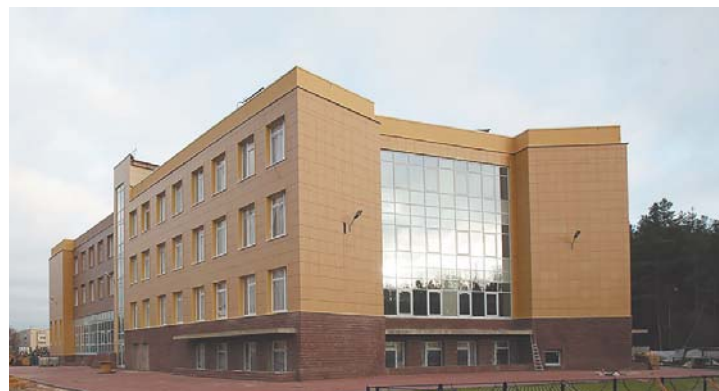
Строительство Детской школы искусств в г. Ломоносове
