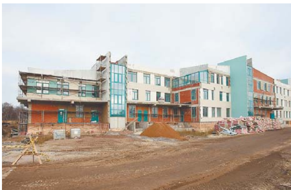
Строительство поликлиники в пос. Стрельна
