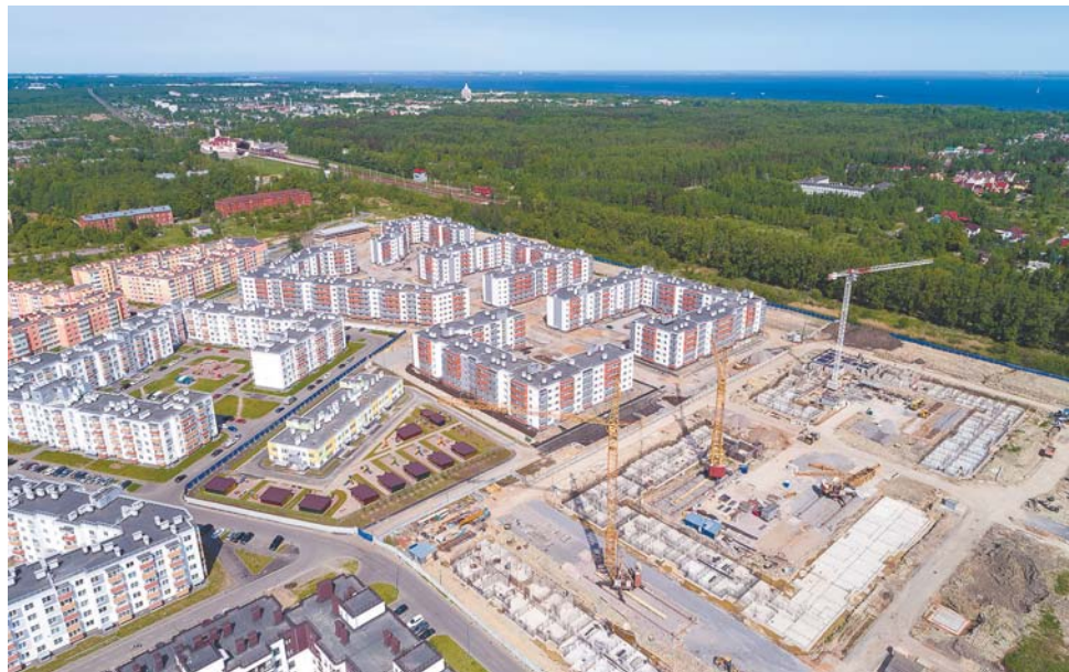
Строительство жилого микрорайона на Ропшинском шоссе
