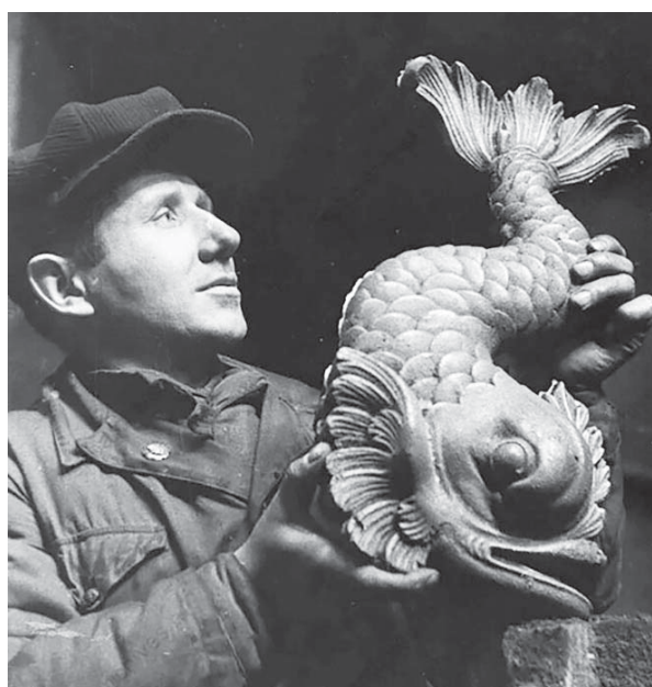
Начальник цеха фасонного литья завода «Лентрубли» И. П. Евграфов осматривает пробную отливку детали решетки для Аничкова моста. 20 апреля 1944 г.
